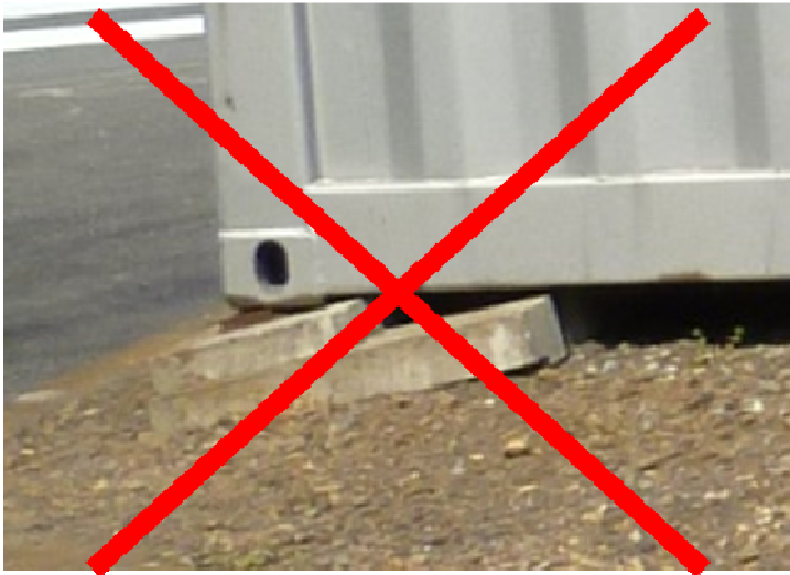
町で見かける違法トランクの例 基礎を打たず、非常に危険な状態です
